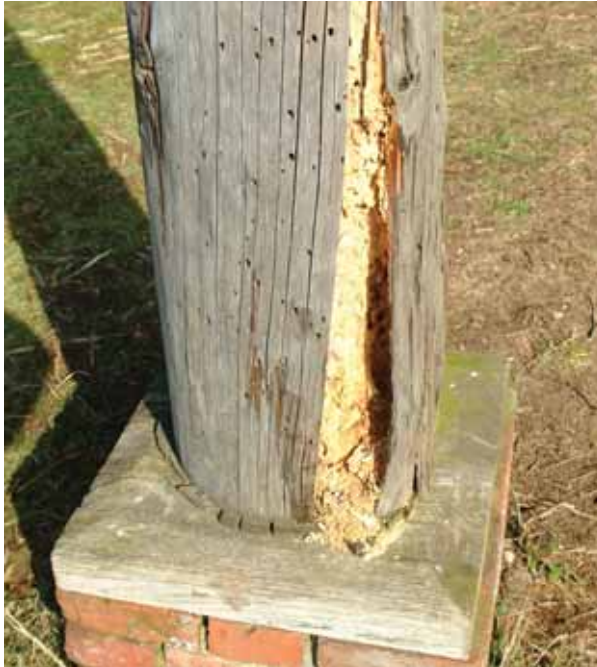
Vraatsporen van de boktor in een paal van de Kapschuur van Oldambster boerderij uit Beerta, Nederlands Openluchtmuseum.
