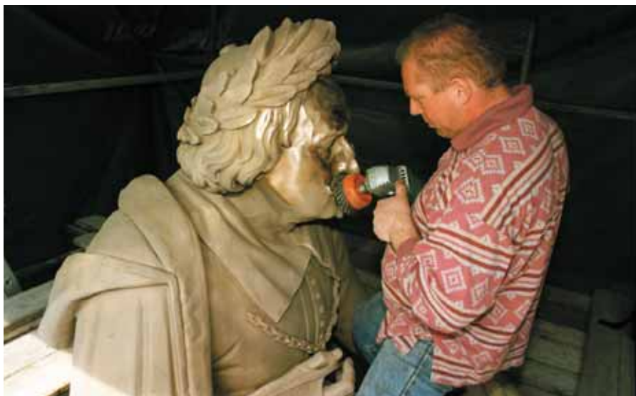
Polijsten van het Amsterdamse Vondelbeeld na gritstraalbehandeling, waarbij het oorspronkelijke patina verloren ging. Deze restauratie leidde in de jaren negentig tot een controverse in de media en de gemeentelijke politiek. Foto: ANP/Martin Mooij.
