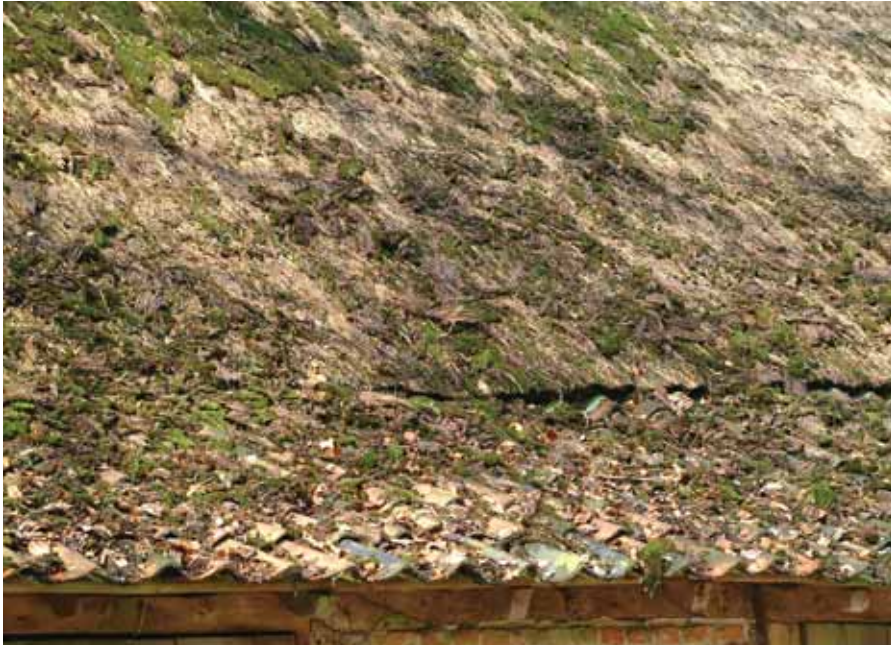
Mos en bladeren op de rieten kap van de laaggevelige boerderij uit het Brabantse Budel, Nederlands Openluchtmuseum.
